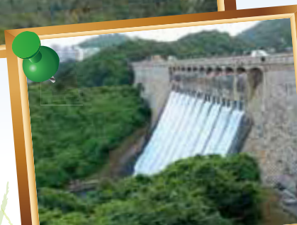
大潭篤水塘水壩 Tai Tam Tuk Reservoir Dam
