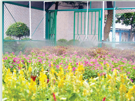
設置加壓泵，收集山水，建立灌溉系統，既能易於花王保養，又可實踐環保
