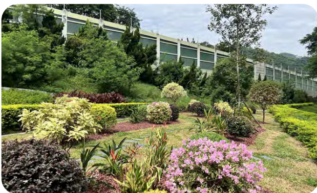
位於沙田區沙田路與大涌橋路交界處的綠化地帶，是園景改善工作成功實例。
