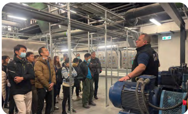
游泳池機房操作員證書課程的學員參觀東昌街游泳池的機房。該機房是全港其中一個最先進的游泳池機房。
