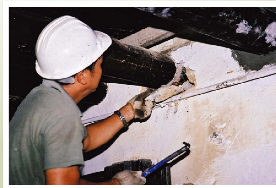
2006年進行的維修工程 Repair works in 2006
